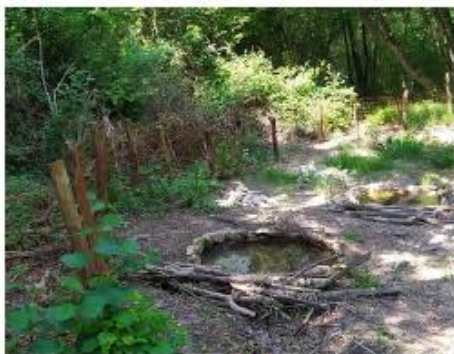
Vaschette neofornate. Base di malta cementizia su una struttura "portante" di rete metallica zincata (immersa completamente nella matrice di fondo); pietre di calcare raccolte localmente, cercando di scegliere quelle più appiattite, cementate ed avvicinate l'una all'altra più possibile. Tubo in polietilene di collegamento con il ruscello a monte, su uno dei lati maggiori (Foto C. Soccini).
