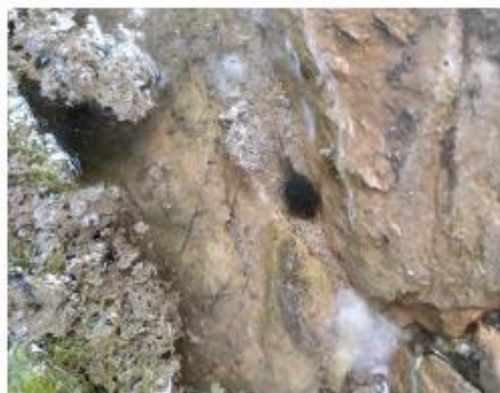
Vaschette neofornate. Base di malta cementizia su una struttura "portante" di rete metallica zincata (immersa completamente nella matrice di fondo); pietre di calcare raccolte localmente, cercando di scegliere quelle più appiattite, cementate ed avvicinate l'una all'altra più possibile. Tubo in polietilene di collegamento con il ruscello a monte, su uno dei lati maggiori (Foto C. Soccini).
