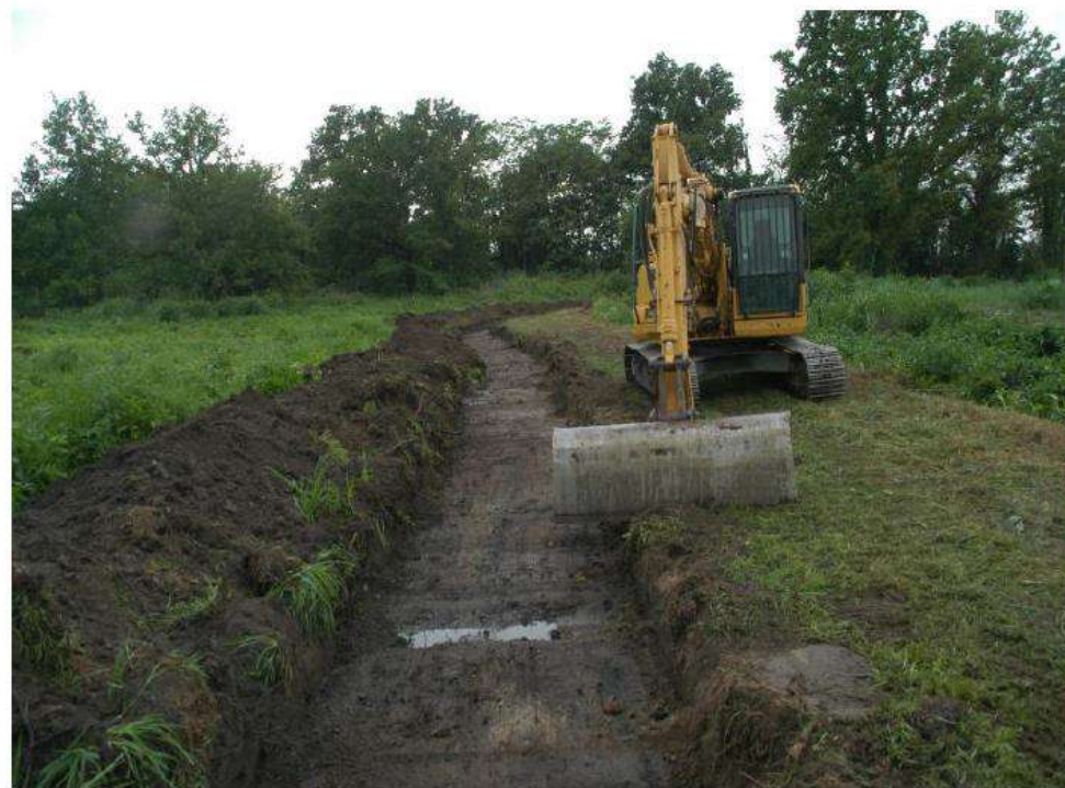
Figura 20. Azioni preliminari: escavazione di una trincea di stoccaggio e posizionamento di una rete metallica che funge da barriera all'eventuale diffusione di propaguli della pianta durante l'intervento (Foto Luca Gariboldi).
