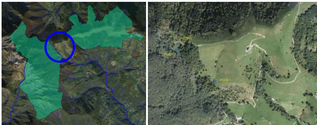
Fig. 1 – A sinistra: ubicazione dell'area di intervento (cerchio blu) rispetto alle ZPS IT2060301 e IT2060302 (in verde). A destra: ubicazione esatta delle pozze.
