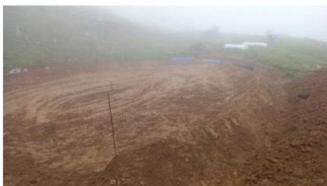
Pozza 1 – lavori in corso
