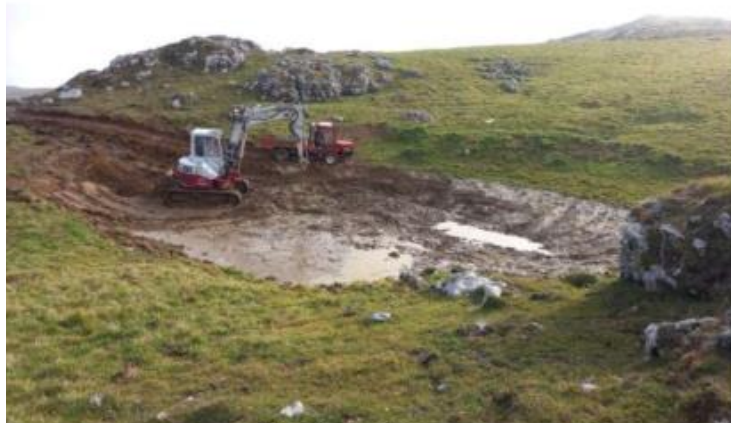
Pozza 3 – lavori in corso
