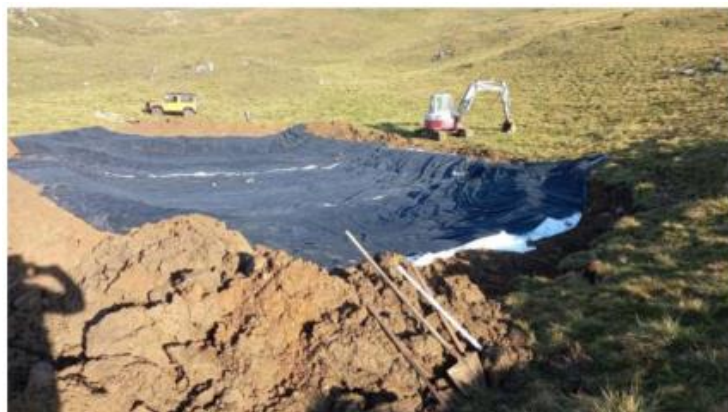
Pozza 2 – lavori in corso
