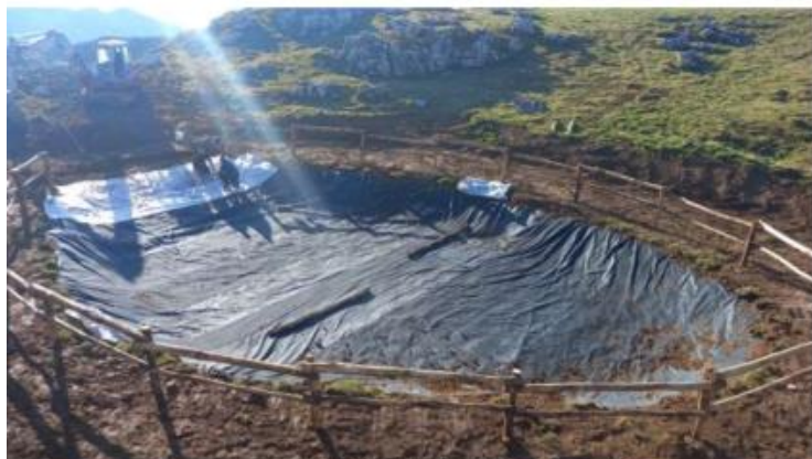
Pozza 3 – lavori conclusi
