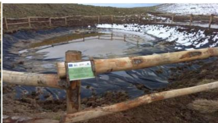
Pozza 2 – lavori finiti
