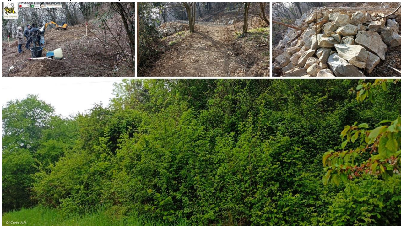
Figura 2.2.1. Lavori preliminari di pulizia e consolidamento area della struttura outdoor
