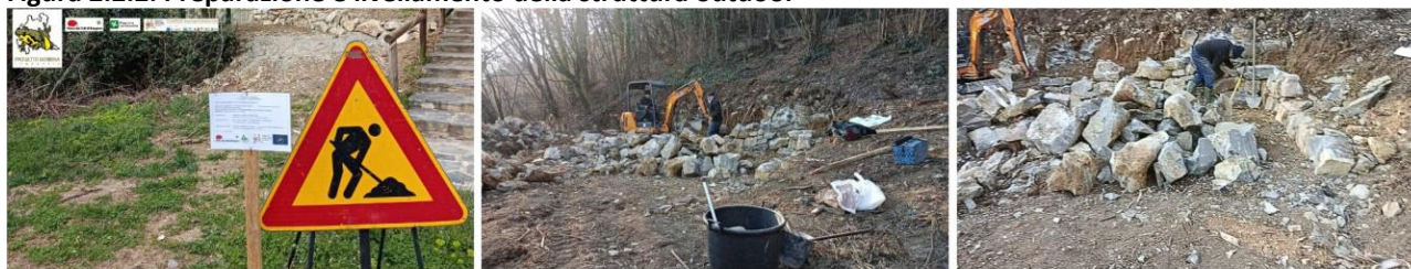
Figura 2.2.2. Preparazione e livellamento della struttura outdoor
