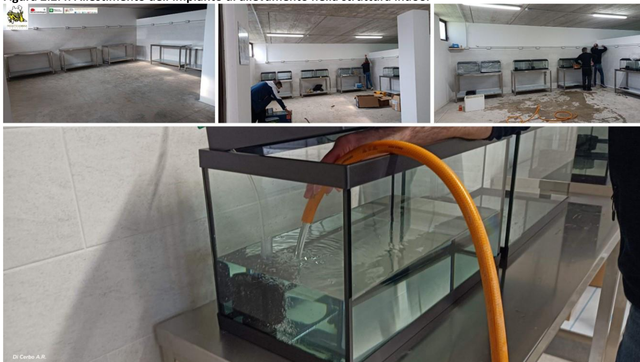
Figura 2.2.4. Allestimento dell'impianto di allevamento nella struttura indoor
