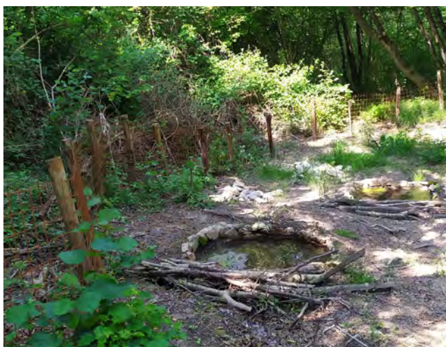
Vaschette neoformate. Base di malta cementizia su una struttura “portante” di rete metallica zincata (immersa completamente nella matrice di fondo); pietre di calcare raccolte localmente, cercando di scegliere quelle più appiattite, cementate ed avvicinate l'una all'altra più possibile. Tubo in polietilene di collegamento con il ruscello a monte, su uno dei lati maggiori (Foto C. Soccini).
