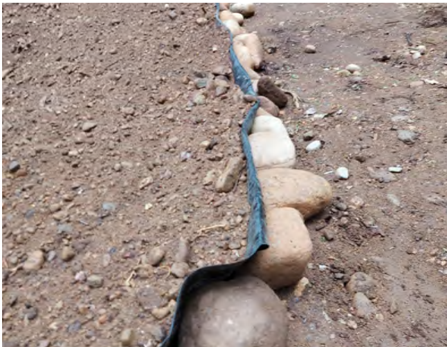
Rialzo del bordo: accorgimento per evitare la perdita di acqua per capillarità del terreno circostante. Stagno completato (foto A. Longo)
