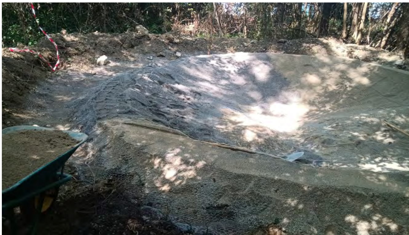
Dopo lo scavo ed il modellamento dell'invaso, la posa di una rete anti-intrusione di piccoli roditori e talpe, di guaine di geotessuto ed uno strato di sabbia, è stato posato un telo EPDM, ricoperto infine da terriccio grossolano e non fertile (Foto E. Carturan).
