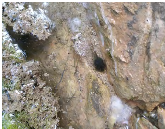
Vaschette neoformate. Base di malta cementizia su una struttura “portante” di rete metallica zincata (immersa completamente nella matrice di fondo); pietre di calcare raccolte localmente, cercando di scegliere quelle più appiattite, cementate ed avvicinate l'una all'altra più possibile. Tubo in polietilene di collegamento con il ruscello a monte, su uno dei lati maggiori (Foto C. Soccini).
