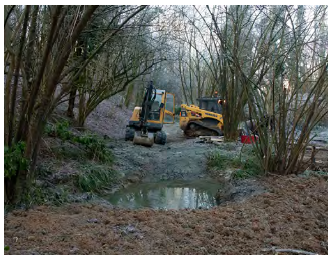
Realizzazione di pozza, scavo, pulizia vegetazione e posa staccionata per limitare l'accesso (Foto G. Ballardini)
