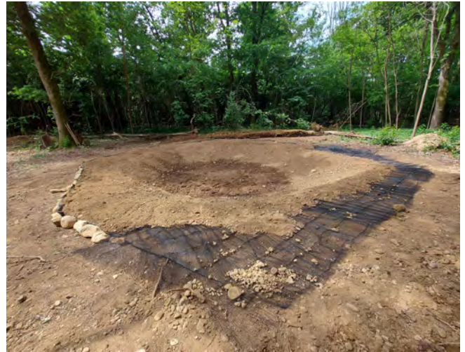
Posa del telo impermeabile e della rete plastificata per favorire la tenuta della terra, non sempre, nella realizzazione degli stagni viene inserito questo strato ma è consigliato perché favorisce la miglior distribuzione e tenuta del terreno. Posa della terra (foto A. Longo)
