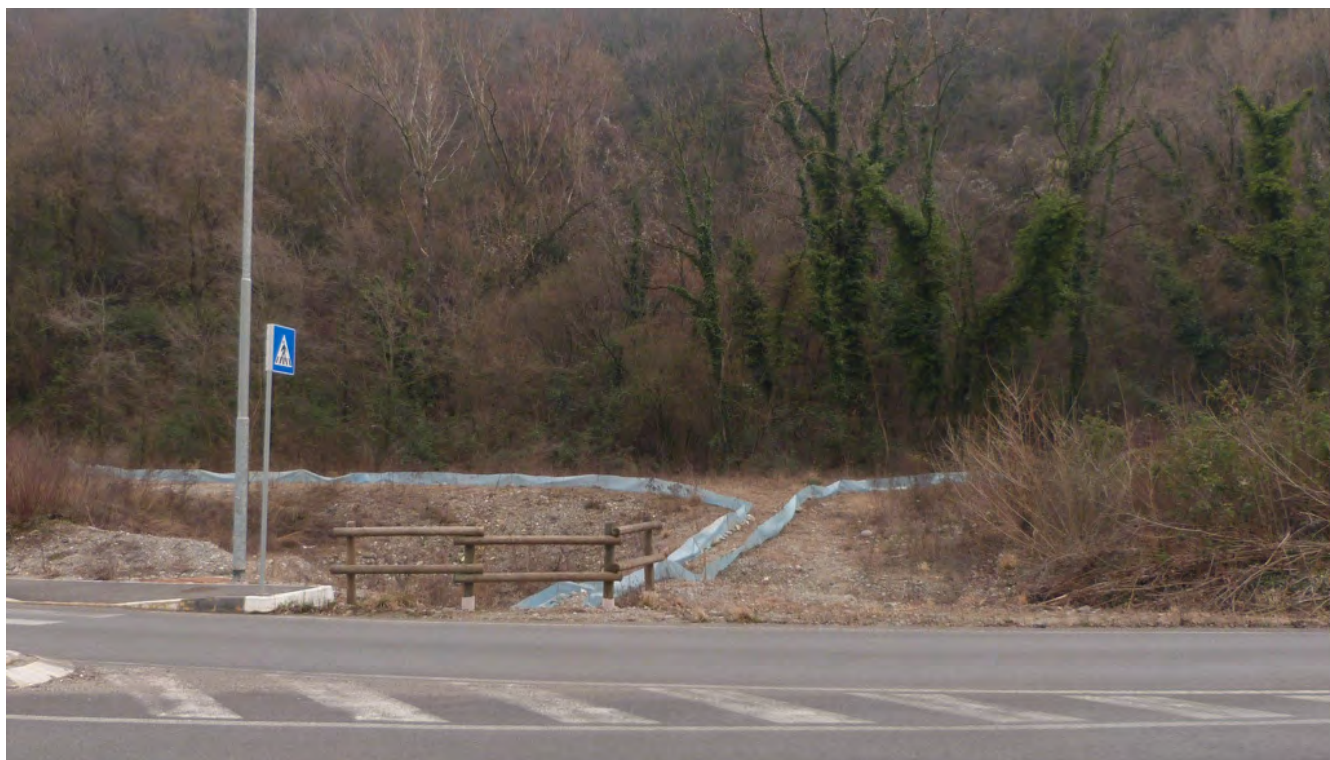
Barriera di invito verso il tunnel stradale (Clusane, BS, Foto C. Soccini)
