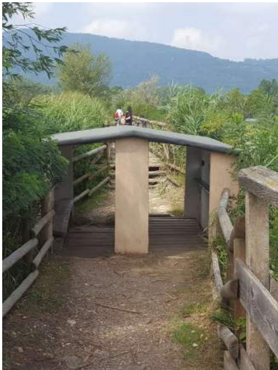
Riserva Naturale delle Torbiere del Sebino (BS) Struttura di osservazione aperta, lungo il percorso di visita, realizzata in muratura e pannelli di legno
