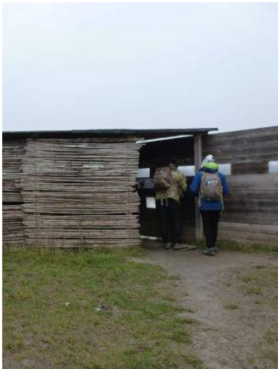
Riserva Naturale Regionale della Foce dell'Isonzo (GO) ZPS Foce dell'Isonzo - Isola della Cona Struttura aperta per l'osservazione, in legno e bambù
