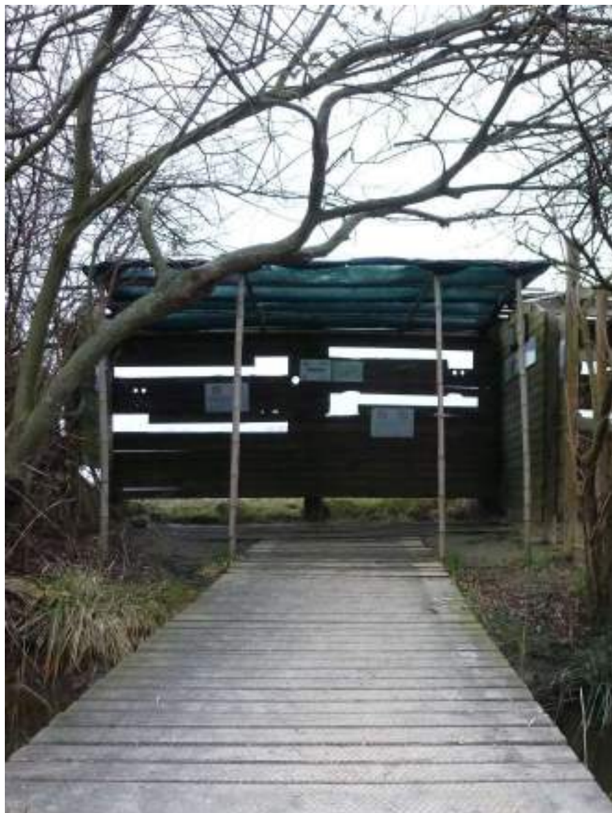
Riserva Naturale Regionale della Foce dell'Isonzo (GO) ZPS Foce dell'Isonzo - Isola della Cona Struttura di osservazione temporanea, in legno, bambù e tessuto
