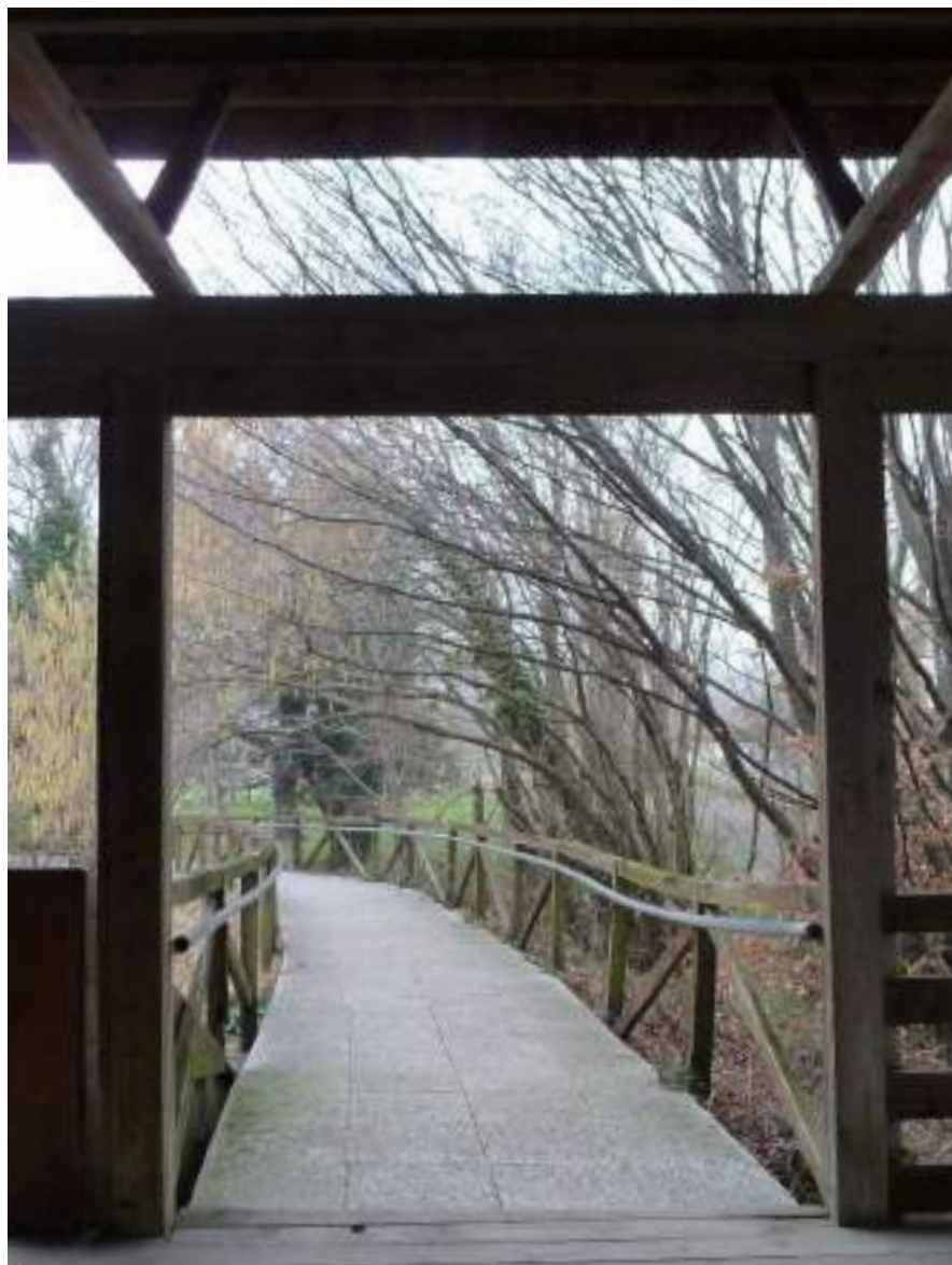
Riserva Naturale Regionale della Foce dell'Isonzo (GO) ZPS Foce dell'Isonzo - Isola della Cona Percorso con fondo di mattonelle in graniglia. Il corrimano, in aggiunta al parapetto, aiuta i movimenti delle persone con difficoltà nella deambulazione
