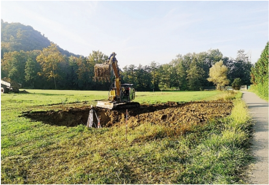
A sinistra, come si presenta ora il terreno con l'inizio dello scavo per la fossa di zona umida profonda 1,3 metri. A destra, il laghetto come sarà al termine dei lavori
