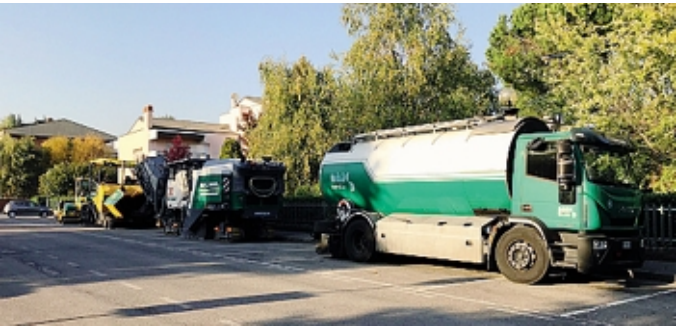
Macchine asfaltatrici già in azione per le strade di Brusaporto
