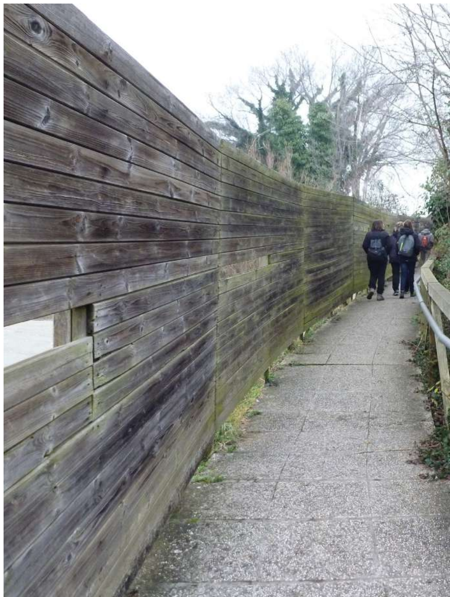
Riserva Naturale Regionale della Foce dell'Isonzo (GO) ZPS Foce dell'Isonzo - Isola della Cona Schermatura in legno. Le feritoie permettono di fare brevi avvistamenti anche lungo i percorsi. Il corrimano, in aggiunta al parapetto, aiuta i movimenti delle persone con difficoltà nella deambulazione
