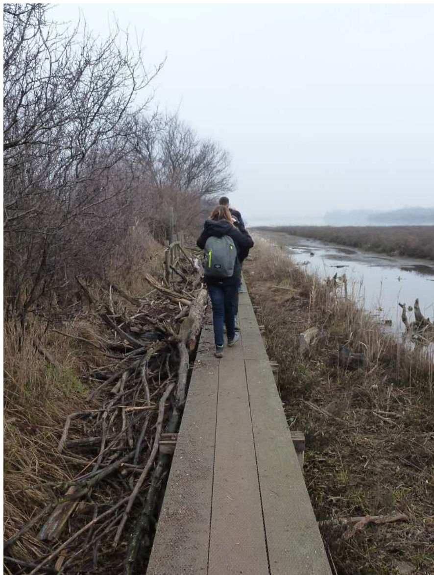
Riserva Naturale Regionale della Foce dell'Isonzo (GO) ZPS Foce dell'Isonzo - Isola della Cona Passerella in legno lungo un sentiero fangoso. Una leggera rete metallica sui percorsi in legno evita che diventino scivolosi a causa dell'umidità. La distanza tra le assi in legno deve essere inferiore ai 10 mm
