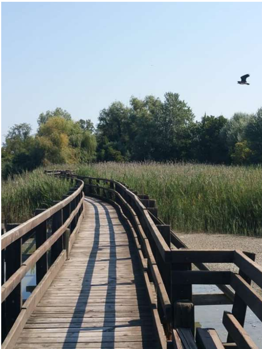
Laguna di Marano (UD) Passerella in legno sospesa sulla laguna I piccoli cordoli ai lati impediscono cadute (soprattutto con sedia a rotelle) e aiutano a orientare le persone ipovedenti
