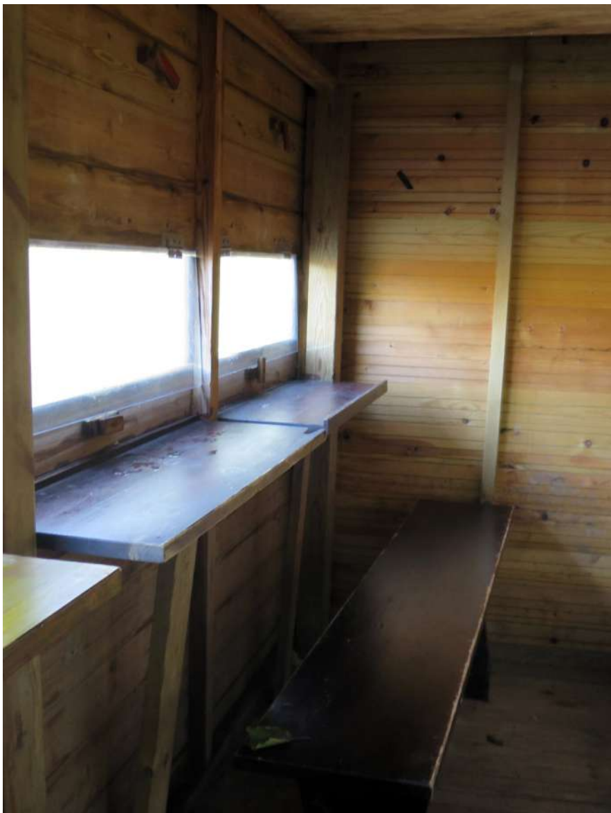
Riserva Naturale Palude Brabbia - Inarzo (VA) Oasi Lipu Feritoie con panche corte e mensole di appoggio. Le mensole hanno rinforzi sottostanti al piano d'appoggio che distribuiscono il carico sulla parete e sul pavimento.
