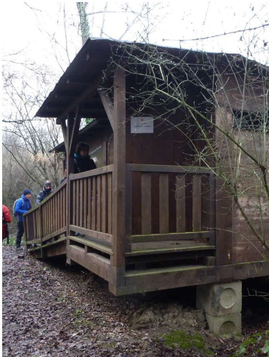
Riserva Naturale di Torrile e Trecasali (PR) Oasi Lipu Capanno rialzato rispetto al terreno, accessibile tramite una passerella
