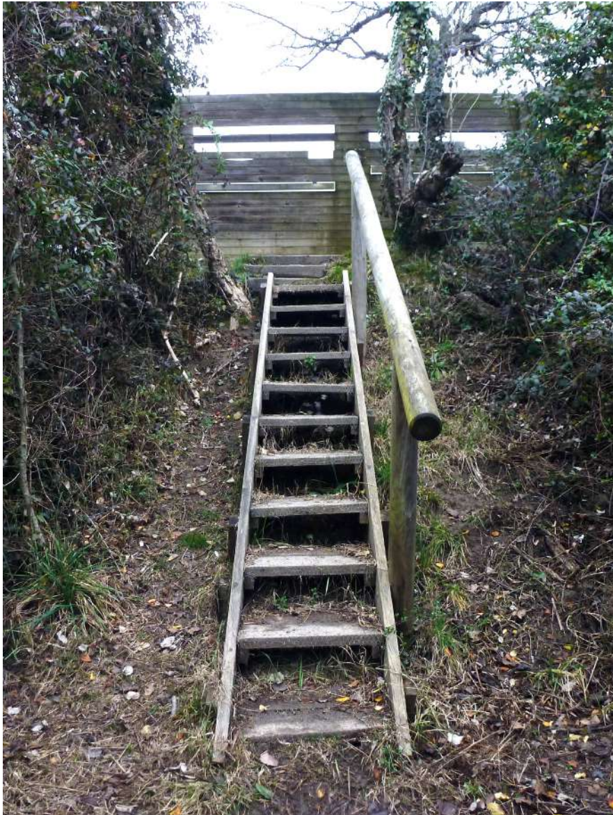
Riserva Naturale Regionale della Foce dell'Isonzo (GO) ZPS Foce dell'Isonzo - Isola della Cona Scale d'accesso in legno a una struttura di osservazione posta su un argine
