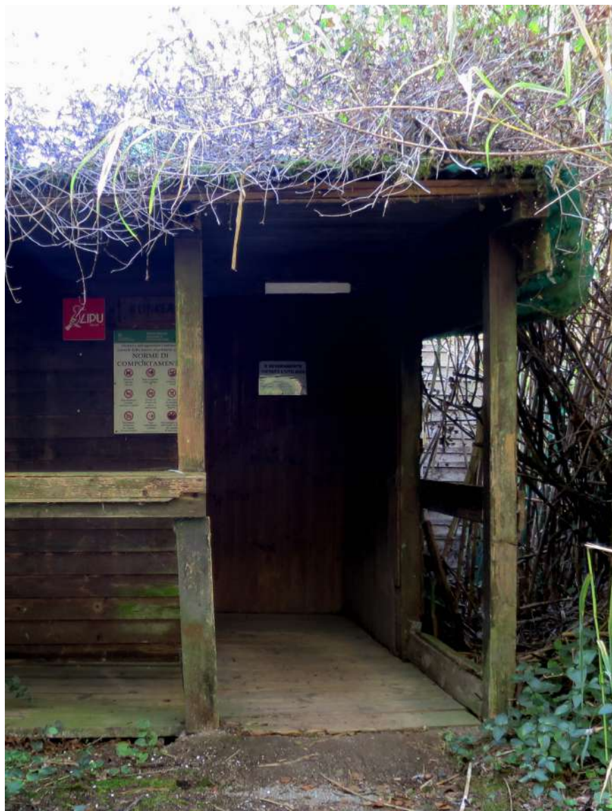
Riserva Naturale di Torrile e Trecasali (PR) Oasi Lipu Capanno in con tetto in legno con rivestimento misto di materiale plastico ondulato e paglia
