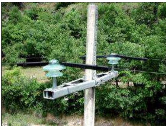
Figure - Esempi di applicazione dei profili in gomma sui conduttori e isolatori in tensione. Foto: ENEL.
