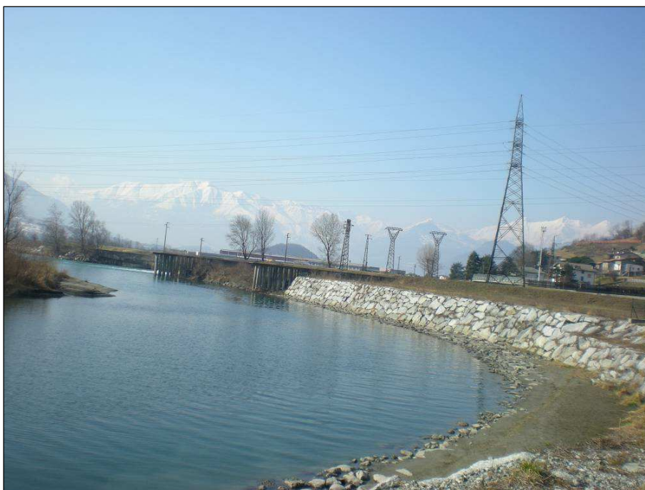
Figura - Linee ad Alta e Media Tensione a rischio elevatissimo di collisione presso la Centrale ENEL di Dubino in provincia di Sondrio. Foto: E. Bassi.
