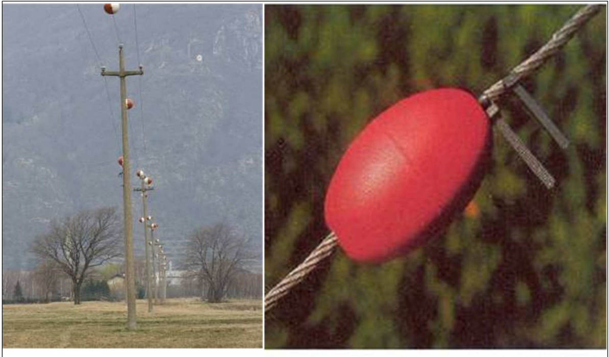
Figure - Applicazione di dispositivi di segnalazione anticollisione per l'avifauna (boe in poliuretano). Foto R. Bionda ed ENEL.
