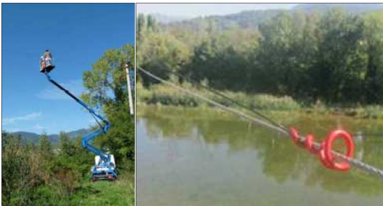
Figure - Fase di intervento per la mitigazione dell'impatto delle linee elettriche a media tensione (a sx) e dettaglio di una delle spirali colorate anti collisione installate sulla linea elettrica a Ranica. (Foto E. Bassi).
