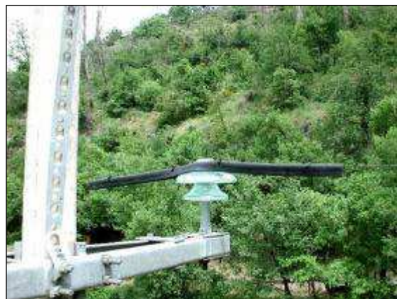
Figure - Esempi di applicazione dei profili in gomma sui conduttori e isolatori in tensione. Foto: ENEL.
