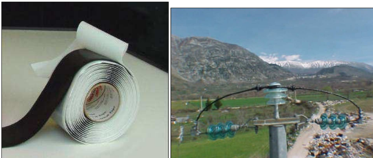
Figure - Il nastro auto agglomerante come valida alternativa da utilizzarsi per le parti di più difficile isolamento: esempi di applicazione del nastro sui sostegni di linee MT. Foto ENEL.
