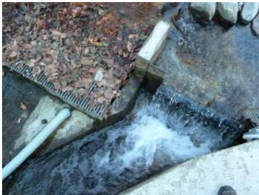
Fig 3 – Soglia di misurazione all'estremità della briglia, in sinistra orografica.
