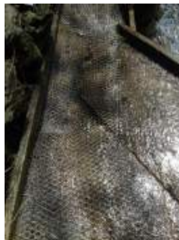
Fig 6 e 7 - dettagli costruttivi: bordatura assito e rete a maglie strette
