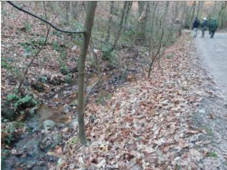
Fig 5 – uno dei tratti dell'alveo affiancato dalla viabilità di accesso all'area
