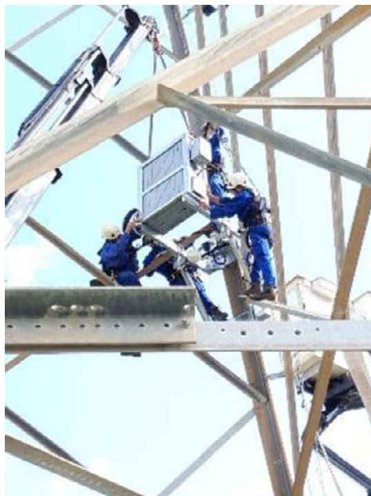
Alloggiamento del Cabinet sul telaio in acciaio
