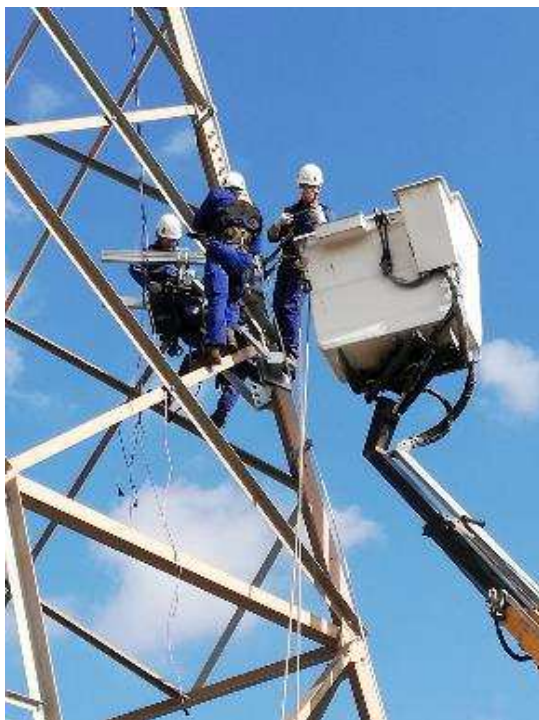
Installazione delle Carpenterie assemblate
