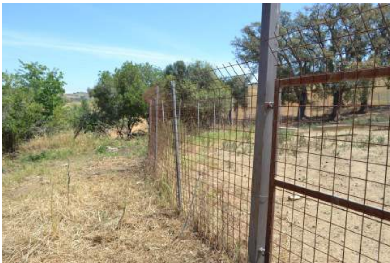
Fig. 37 – Recinzione metallica fissa non elettrificata
