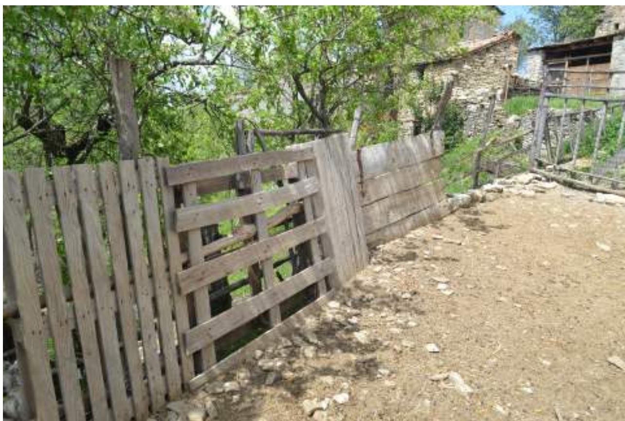
Fig.18 – Recinzione artigianale per ovini non elettrificata h= 110\text{ cm}
