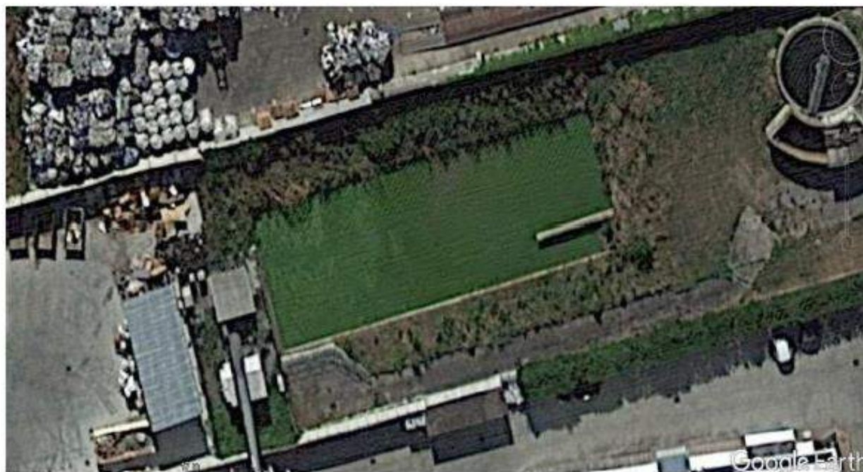
Figura 41. Il vascone in cemento presente nell'area del dismesso depuratore di San Daniele Po: dopo una mirata ristrutturazione e la garanzia di un sufficiente benessere a lungo termine per gli individui ospitati, verrà destinato a Centro di stabulazione permanente locale di Trachemys scripta .
